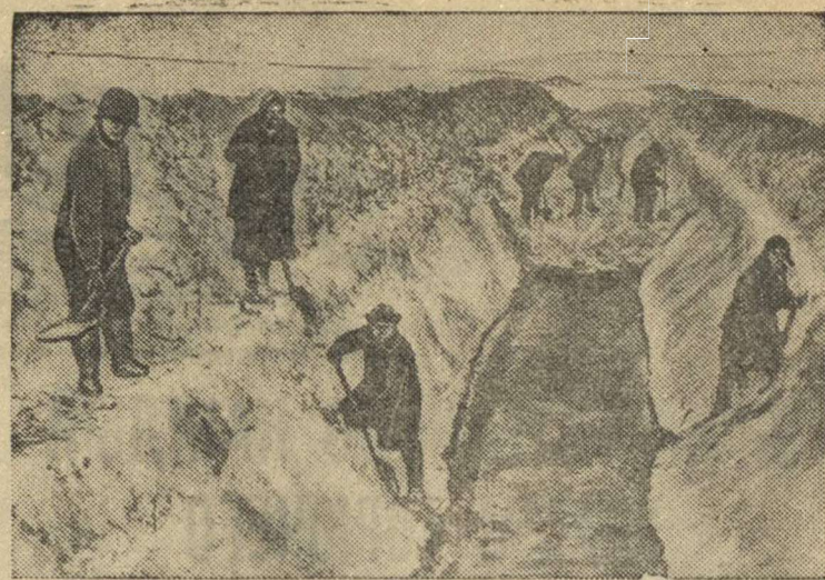
В колхозе «Чырвоная Гусараўка» (Рогачевский район, Гомельская область БССР) организована круглогодичная работа по осушению болот. На болотах проложена центральная магистраль длиной в 506 погонных метров. Работа на центральной магистрали.
