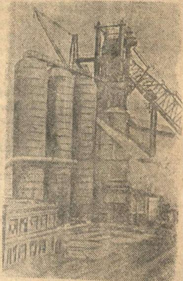
Выполняя задание Партии и Правительства, коллектив Тагилстроя НКВД закончил строительство и сдал в эксплуатацию на Н. Тагильском металлургическом и коксохимическом заводах доменную печь № 3 об'ем 1050 кубических метров и производительностью 400 тысяч тонн чугуна в год и коксовую батарею № 4 производительностью 450 тысяч тонн кокса в год с химическими цехами.
