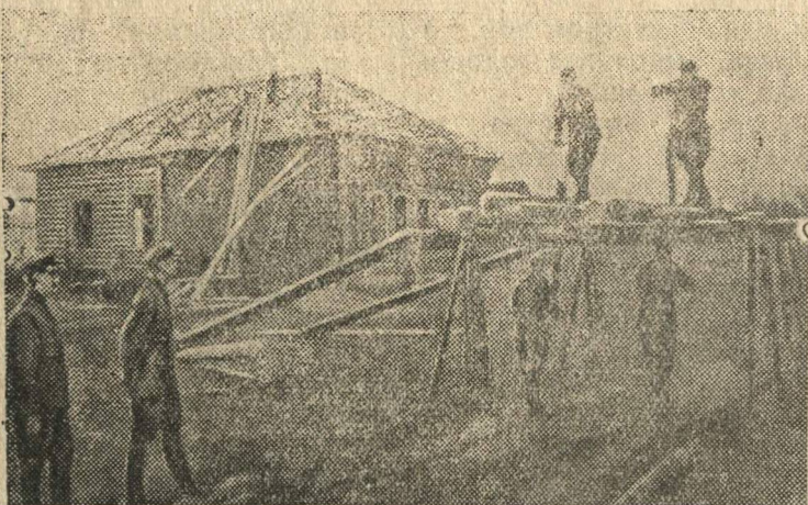
Бойцы Н-ской части строят новую школу в колхозе дер. Игумново (Можайский район), разоренной гитлеровцами.
