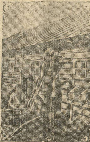
На снимке: животноводческая бригада колхоза имени 8 марта (Кохомский район, Ивановская область) заканчивает ремонт скотного двора.
