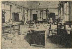
Механическая лаборатория — цементный зал.
