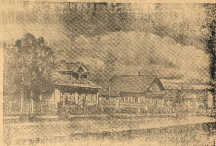
В колхозе «Объединенный труд», Пешехоно-Володарского района, Ярославской области, идет строительство колхозных домов.
