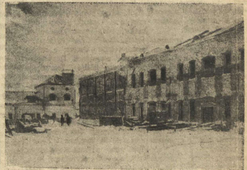
На снимке: Переоборудование бывшего гарного корпуса завода «Трешпель и Поздняк» в ножевой цех. Фото 1927 г.
