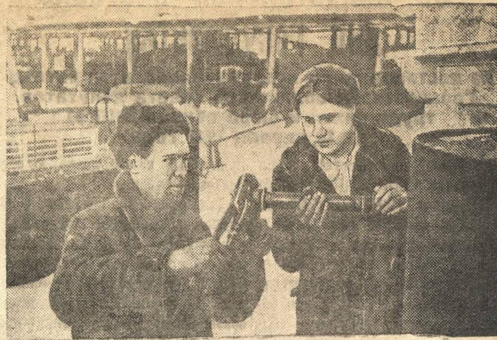
Технический контролер Сыктывкарского затона комсомола З. П. Воронова принимает работу по монтажу газогенераторного котла от слесаря К. П. Шмарина. Фото А. Пельмегова Фотохроника ТАСС
