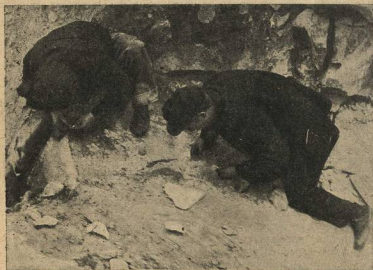
Студенты Горного Института на подрывных работах на Днепрострое
