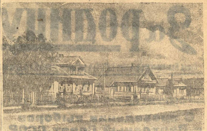
В колхозе «Объединенный труд», Пошехоно-Волдарского района, Ярославской области, идет строительство колхозных домов. На снимке: дома колхозников, построенные в дни Отечественной войны для семей военнослужащих. Фото М. Королева. Фотохроника ТАСС.
