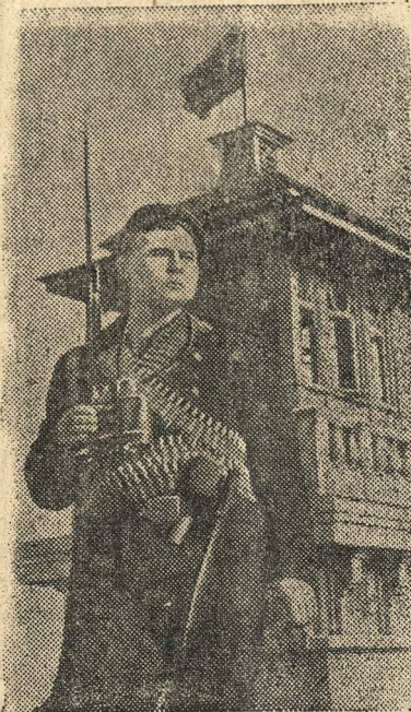
Краснофлотский пост воздушного наблюдения на крыше одного из домов.
