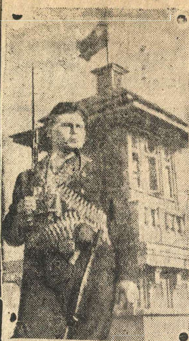
Краснофлотский пост воздушного наблюдения на крыше одного из домов. Фото М. Редкина. Фотохроника ТАСС.
