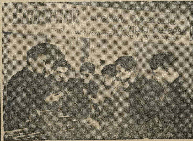
Мастер фрезерного дела ремесленного училища № 8 в г. Киеве Б. М. Дробот объясняет ученикам назначение головки вертикального фрезерного станка. Фото А. Грибовского
