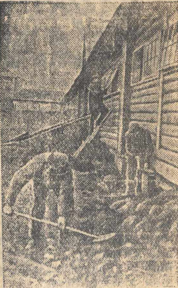
На снимке: Колхозники сельхозартели „Победа XII Октября“ (Пушкинский район, Московская область) ремонтируют и утепляют скотный двор.
