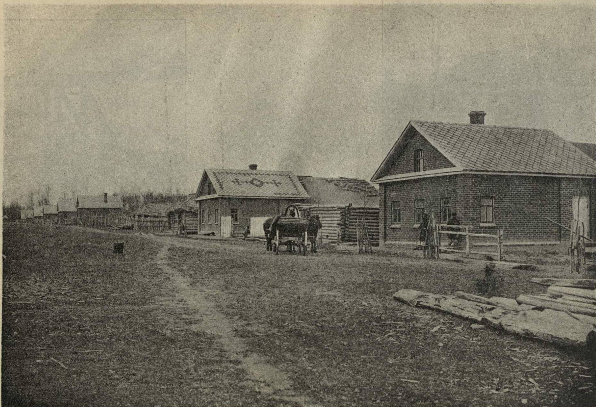
Огнестойкий посёлок „Рябовка“ емангапской вол., васильского уезда. Избы выстроены по способу инженера Герарда и покрыты бетонной черепицей.
