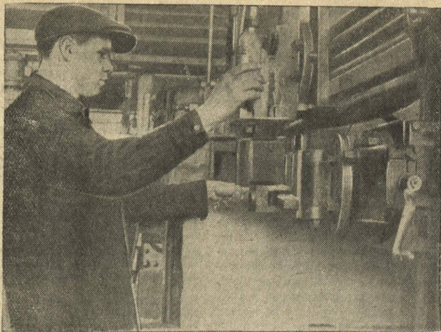
Ф. А. ШМЕЛЕВ, стахановец-строгоальщик отделения крупных штампов инструментально-штампового отдела, на обработке пуансона вытяжного штампа для малолитражного автомобиля выполняет норму до 120 процентов. Фото В. ХРАМЦОВА.
