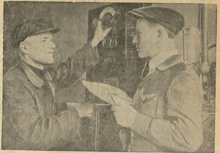
В лаборатории двигателя конструкторско-экспериментального отдела производится работа по повышению экономичности двигателя автомобиля М-1. НА СНИМКЕ: старший техник-испытатель В. Д. СМЕРНОВ (слева) и техник-испытатель А. С. ДЕРБАСОВ определяют октановое число бензина на установке «Воксеша».
