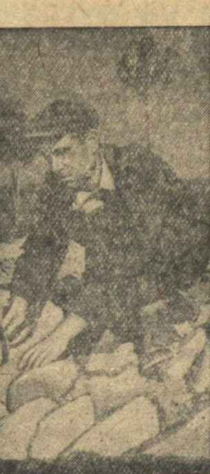
На строительстве дороги Горький — Муром — Куйбыки. Мостовики Б. Степановского колхоза им. Куйбышева. Вацкого района, Е. В. Шугов. За один рабочий день он мостит до 40 кв. метров дороги. На снимке: тов. Шугов за работой. Фото П. Вознесенского.
