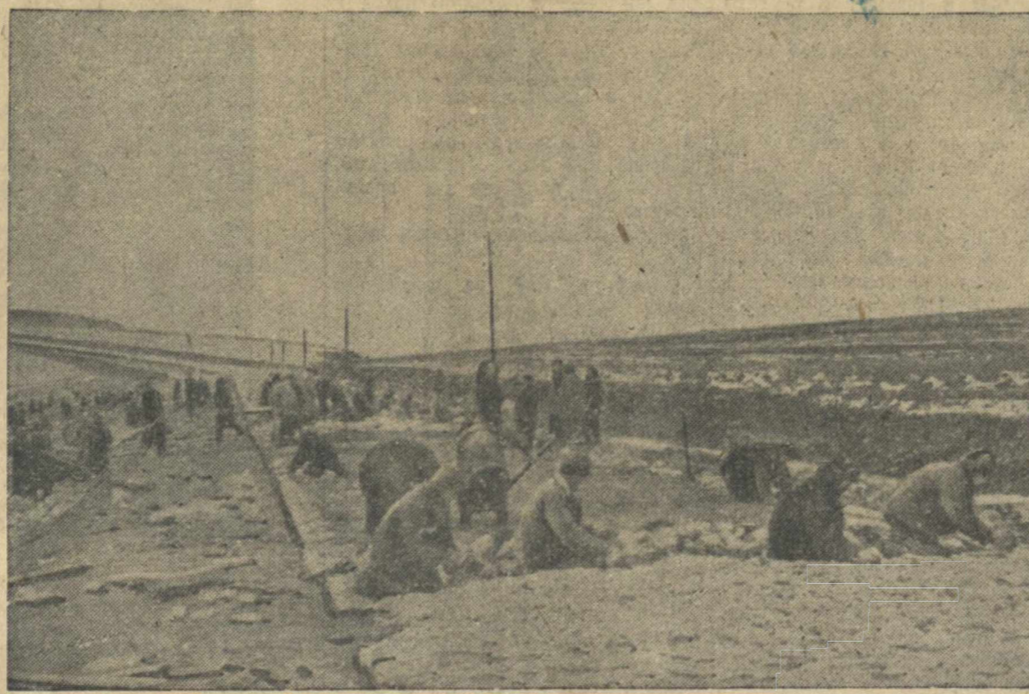
27 октября первым на строительстве дорог Горький—Муром—Кулебаки закончил мощение Кстовского участка. На снимке: укладка камня на последних метрах Кстовского участка. Фото Г. Иванова.
