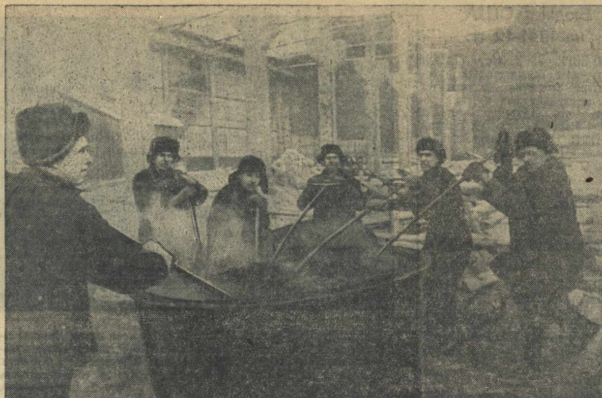
Стахановская бригада кровельщиков, получившая переходящее красное знамя второй конторы промышленно-строительства Стройгаза, за первую декаду декабря выполнила задание на 186 проц. На снимке (слева направо): Г. Г. Миллер (бригадир), В. А. Кайзер, А. Н. Шлейгер, С. Р. Петряков, И. Т. Ерышев и Н. Е. Горчаков за варкой асфальта для кровли моторного цеха.
