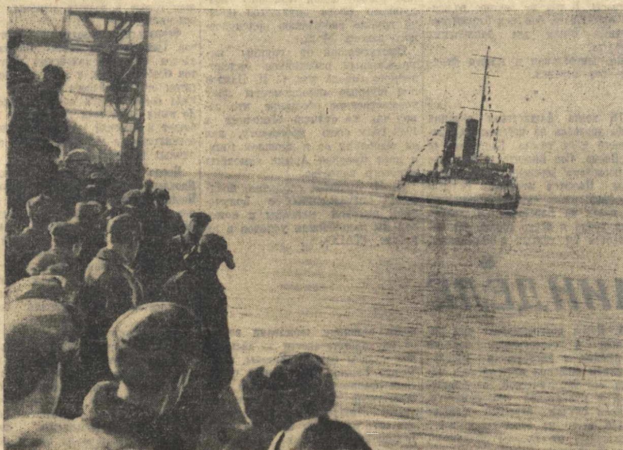
Историческая экспедиция завершена — Ледокол «Ермак» с героями-папанинцами подходит к причалу Ленинградского торгового порта
