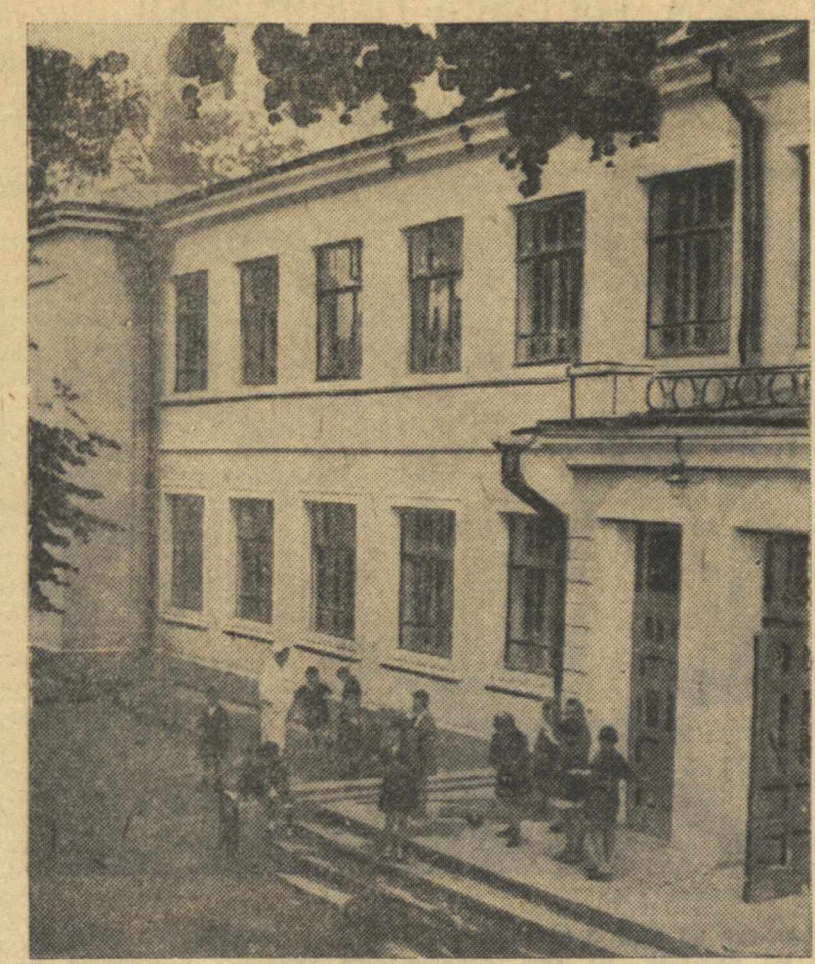
Новый детский сад на 100 детей (Холодный переулок, Свердловский район г. Горького). Фото Г. Иванова.
