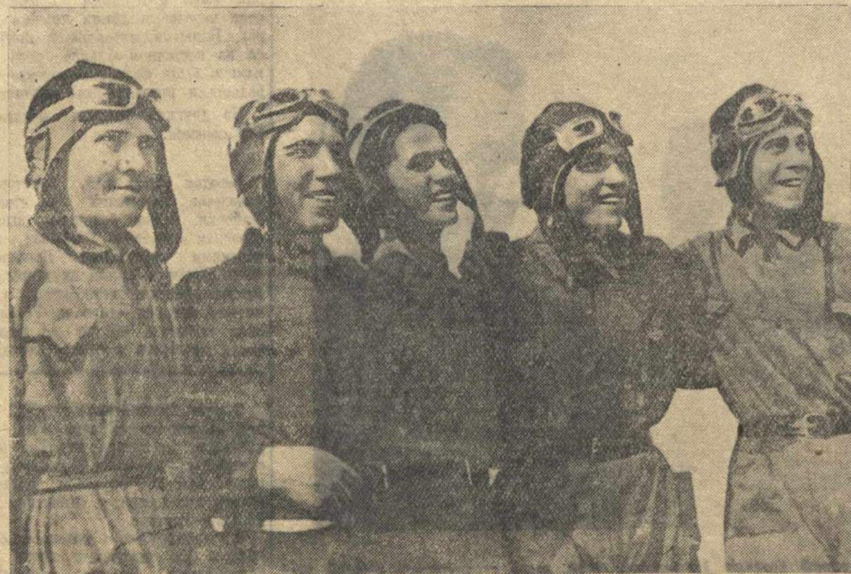
Комсомольцы, рабочие заводов Серовского и Кагановичского районов, учелты - отличники Серовского аэроклуба. Слева направо: Д. Корежов (токарь), А. Павловский (столяр), Л. Салтыков (токарь), С. Бегайкин (строгальщик), В. А. Романов (слесарь). Фото А. Канешова.
