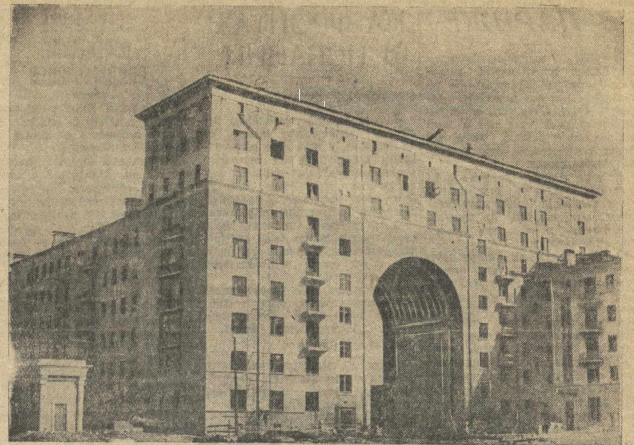
Во втором бусыгинском квартале автозавода им. Молотова закончен стройкой восьмизатный дом. В доме комфортабельные квартиры с ванными, душами и т. д., лифт. В ближайшее время дом будет заселен рабочими автозавода. Фото В. Храмцова.
