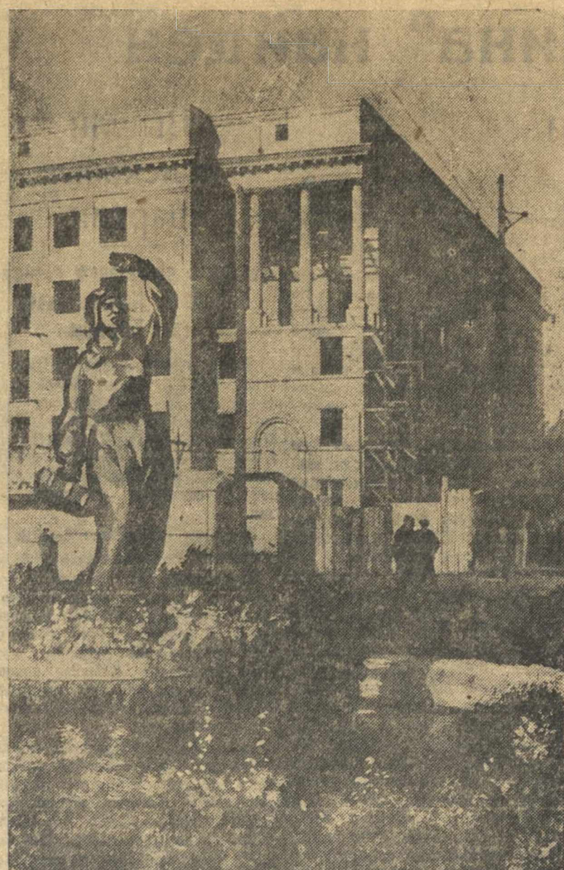
В Сормове на улице Коминтерна с весны нынешнего года строится новый 50-квартирный дом стахановцев. Фото Б. Иванова.
