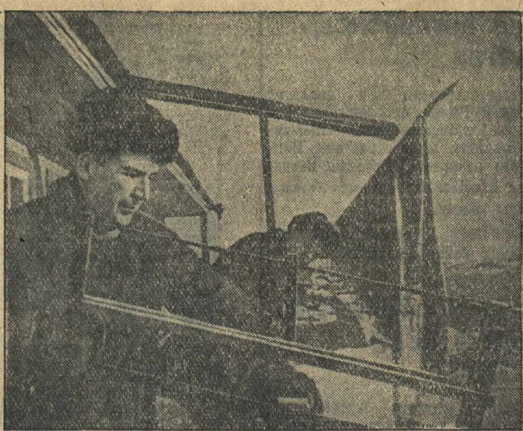
Судоремонтный завод им. К. Маркса В.-В. пароходства за отличную работу получил переходящее красное знамя Наркомата речного транспорта. На снимке: бригадир плотников деревообделочного цеха И. В. Румянцев за ремонтом дебаркадера. Бригада т. Румянцева завоевала переходящее красное знамя завода.
