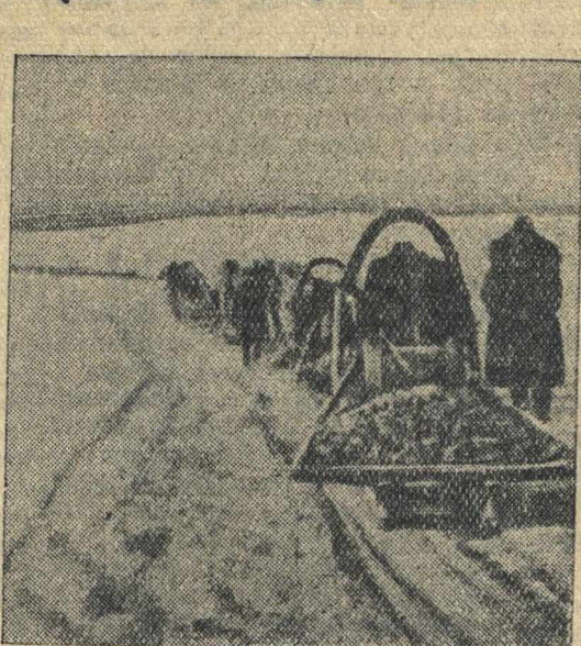
Строительство трассы Горький — Арзамас — Кулебаки. На снимке: колхозники сельскохозяйственной артели «Красный луч», Арзамасского района, вывозят щебень на трассу. Фото Н. Евстигнеева.
