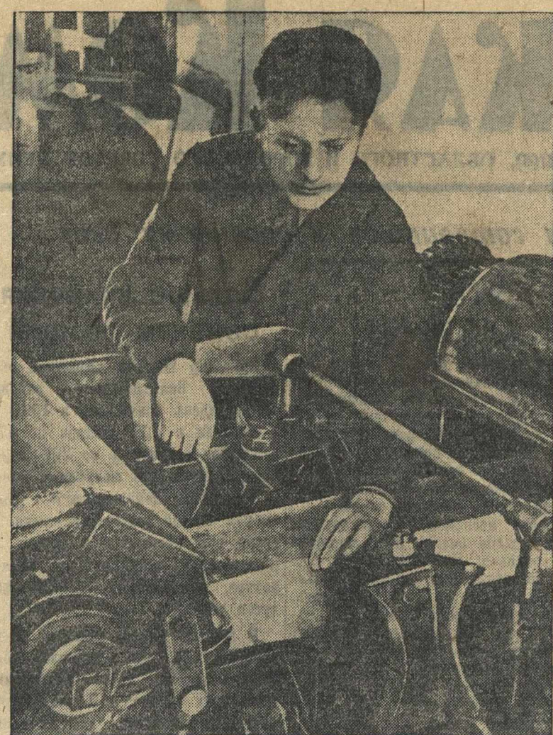
На Горьковском механическом заводе «Красный металлист» изготовлен шпалооправочный станок, дающий возможность обрабатывать все виды шпал. На снимке: изобретатель станка токар М. П. Драчнов (работавший в системе Наркомлеса по внедрению своего изобретения) у центральной части станка, в которой размещены две вращающиеся металлические головки, производящие шлифовку шпал.
