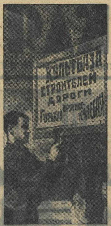
На строительстве дороги Горький — Арзамас — Мулбаши. Культизны колхоза имени 8 марта, Кстовского района, комсомольцы С. Томилоса прикрепили вывеску и избу-читальню, где организована культбаза для строителей дороги. Фото А. Капелюна.
