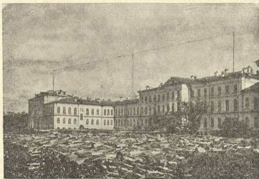
Фот. 3. Задний фасад главного корпуса.
