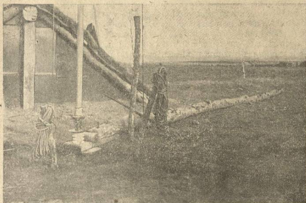
Основаніе трубчатой мачты.
