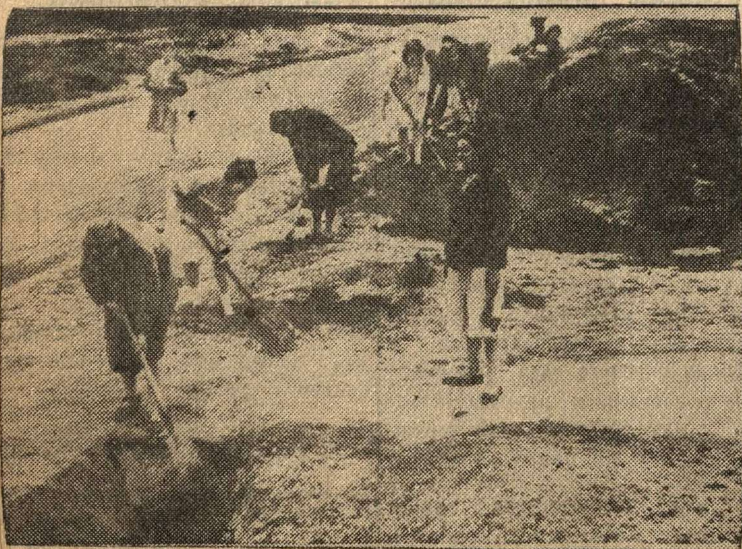
На снимке: Бригада работников отдела технического контроля роет кюветы.
