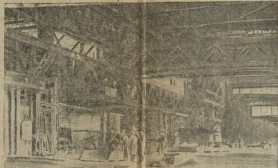
НОВО МАРТЕНОВСКИЙ ЦЕХ. РАБОТА НА ВЕРХНЕЙ ПЛОЩАДИ.
