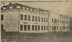
НА СНИМКЕ: новая школа достроена, в которой учатся 250 детей рабочих нашего завода
