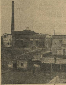
НА СНИМКЕ вид нового трубного цеха.
