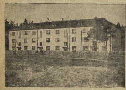
Один из домов заводского рабочего посёлка (улица «Красные зоры») в котором проживают рабочие и ИТР завода.
