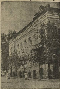
Гор. Каван. На снимке: здание тузовского техникума.
