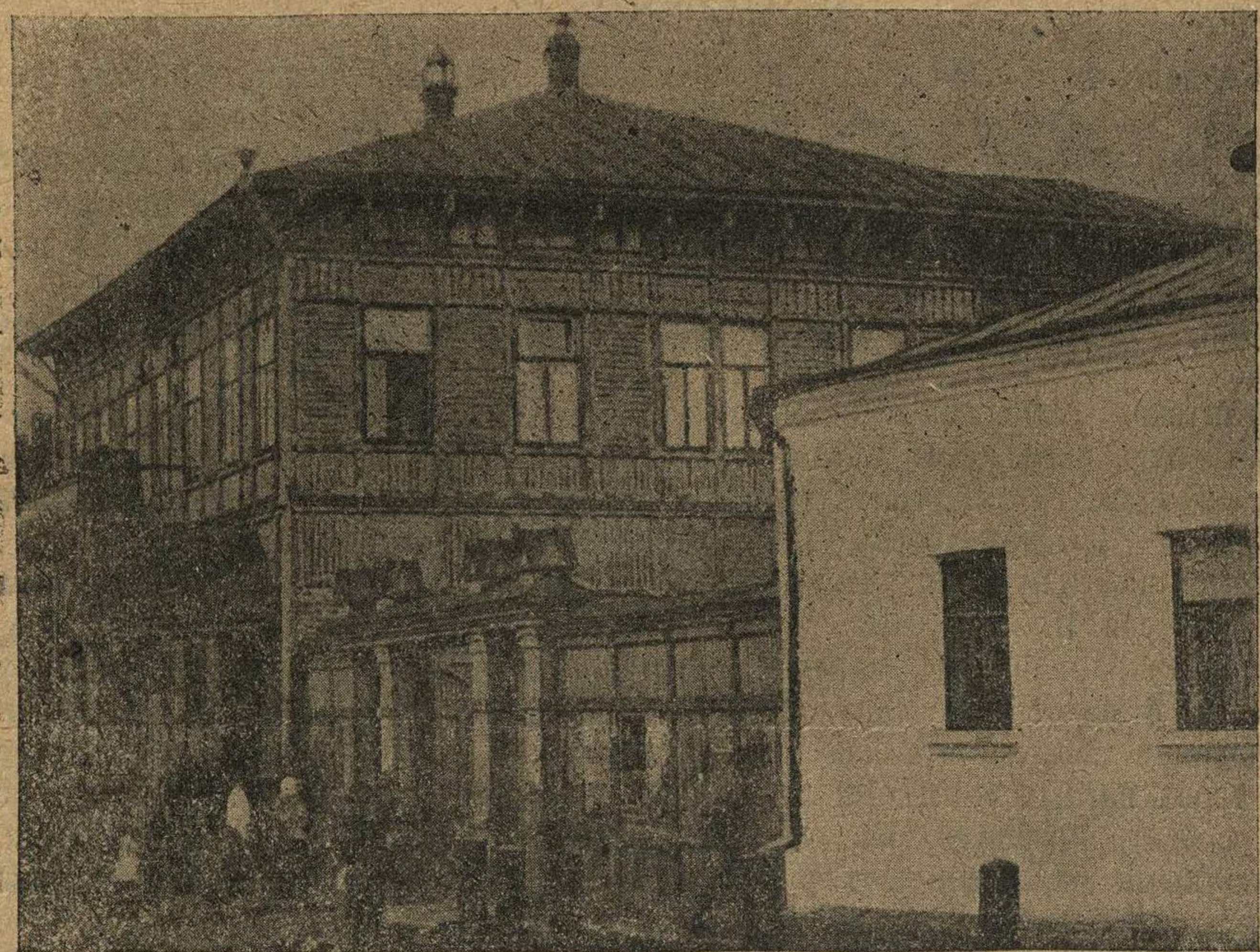
Прошлые года павловские кустари не имели своего клуба. Кустарная молодежь проводила время на улице. К 10-й годовщине Октября открывается клуб кустарей, который заменит и пивную, и бестолковую ул. Клуб обслужит всех кустарей—кооперированных одиночек. На снимке—здание клуба кустарей.
