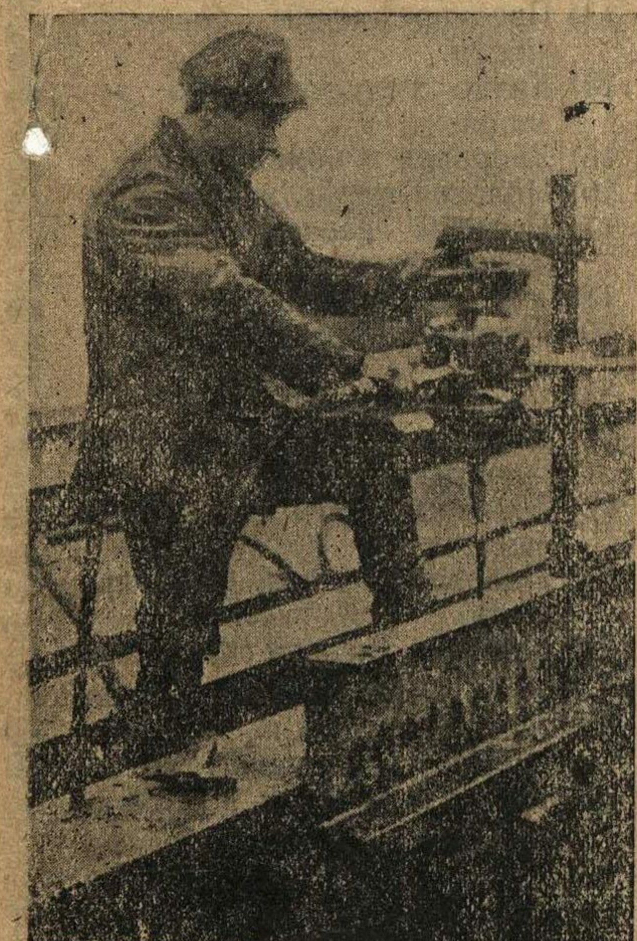
СВЕРЛЕНИЕ ПРИ ПОМОЩИ СЖАТОГО ВОЗДУХА.
