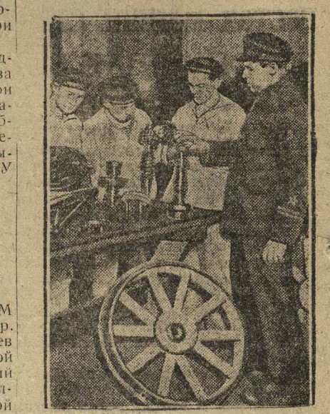
УДАРНИКИ БАЛТФЛОТА. В частях и кораблях Балтфлота, организовавшие ударные бригады приступили к ремонту кораблей своими средствами, не обращаясь к помощи заводов. НА СНИМКЕ: Ударники школы подводного плавания за ремонт двигателя.
