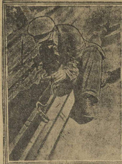
На стройке. Автогенная резка балок.
