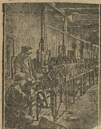
1 мая в Ленинграде на заводе Севкабель открывается крупнейший в Европе цех эмалированной проволоки малых диаметров (0,06—0,02 мм.). НА СНИМКЕ: монтаж оборудования
