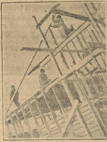
На участке автозавода идет стройка.
