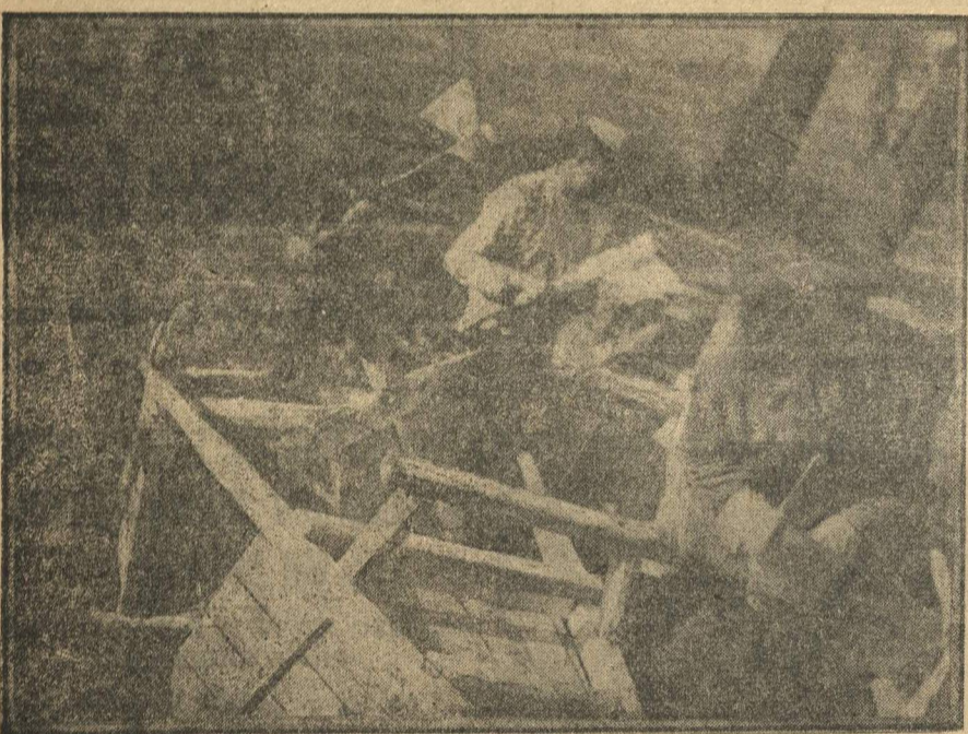
На постройке стадиона в Нижнем.
