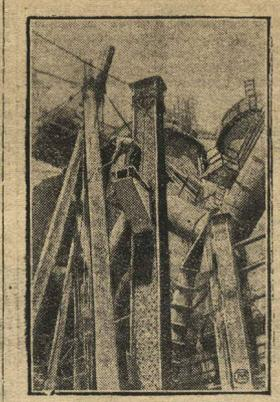
НОВАЯ ДОМЕННАЯ ПЕЧЬ. На Сталинском заводе (Донбасс) начата постройка новой доменной печи № 6. На снимке: установка опорных колонн основного корпуса доменной печи.
