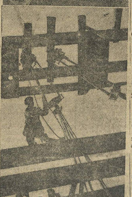
СТРОИТСЯ ОКСКИЙ МОСТ. ПОЛНЫМ ТЕМПОМ ИДУТ РАБОТЫ. НА СНИМКАХ: МОМЕНТЫ РАБОТЫ.
