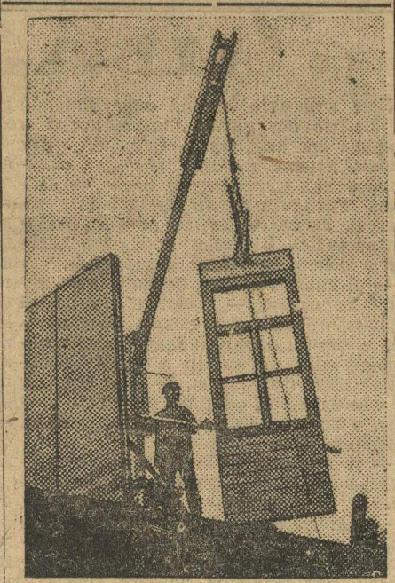
НОВОЕ ЖИЛСТРОИТЕЛЬСТВО. ПОСТРОЙКА СТАНДАРТНОГО ДОМА В СВЕРДЛОВСКОМ РАЙОНЕ.
