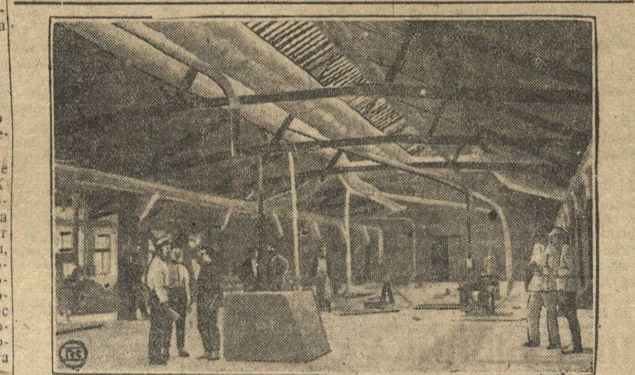
СТРОИТЕЛЬСТВО КИЕВСКОГО ДЕРЕВООБДЕЛОЧНОГО КОМБИНАТА (КИЕВ). В КИЕВЕ ИДЕТ СТРОИТЕЛЬСТВО ДЕРЕВООБДЕЛОЧНОГО КОМБИНАТА, СТОИМОСТЬЮ 8 МИЛЛ. 500 ТЫС. СТРОИТЕЛЬСТВО РАСЧИТАНО НА 3 ГОДА. НА СНИМКЕ: ВНУТРЕННИЙ ВИД РАСПИЛОЧНОГО ЦЕХА (НАВЕРХУ ВИДНА МОЩНАЯ ВЕНТИЛЯЦИЯ, КОТОРАЯ БУДЕТ ВЫТЯГИВАТЬ ПЫЛЬ.
