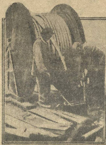
НА СТРОИТЕЛЬСТВЕ. ПРОКЛАДКА КАБЕЛЯ.
