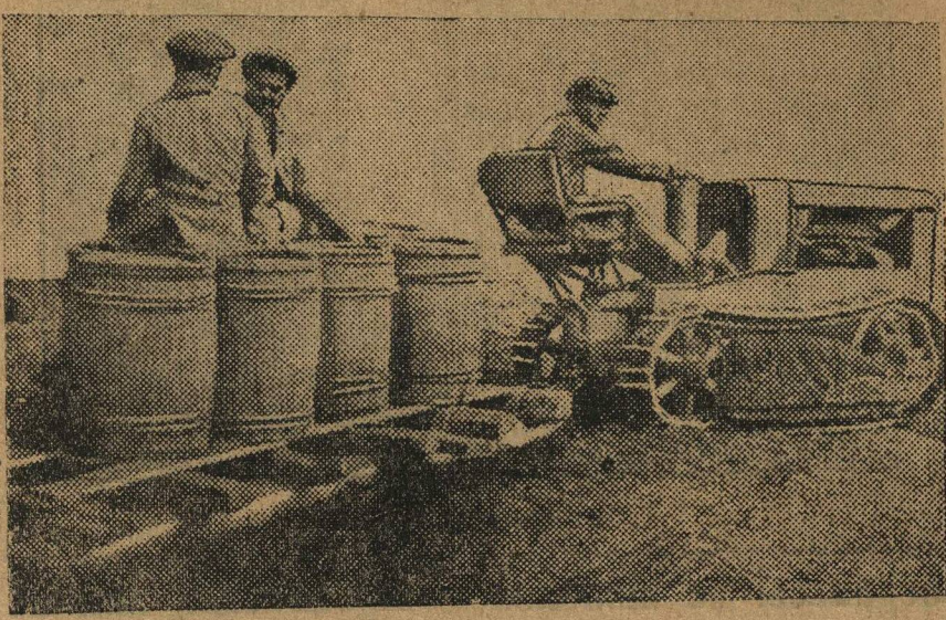
АВТОСТРОЙ. Развозка строительных материалов на тракторе.
