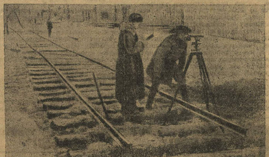
Прокладка рельс трамвайной линии Канавино — Сормово.
