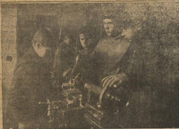
Вновь организовывавшаяся в шурупном цехе (зав. «Кр. Эгна») ударная бригада им. IX съезда ВЛКСМ, в подарок съезду ремонтирует фрезерный станок.
